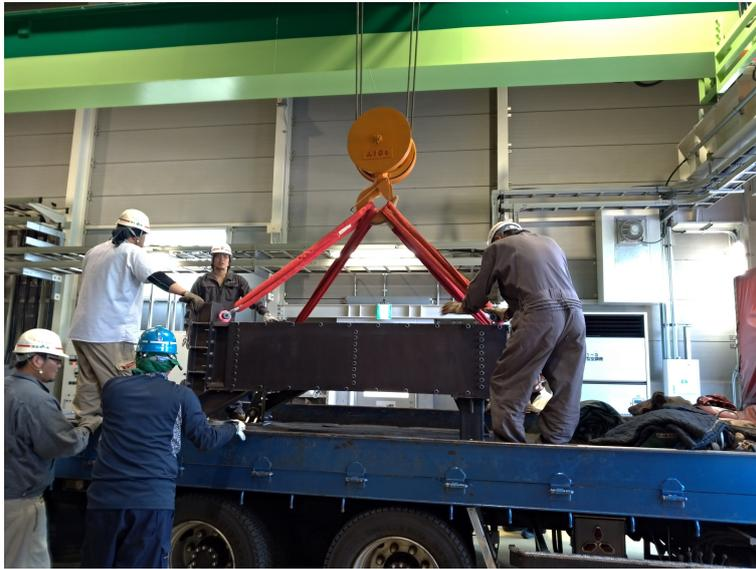
図 50: J-PARC NM 棟に到着し、10t クレーンにより降下されている Wal MRD。
