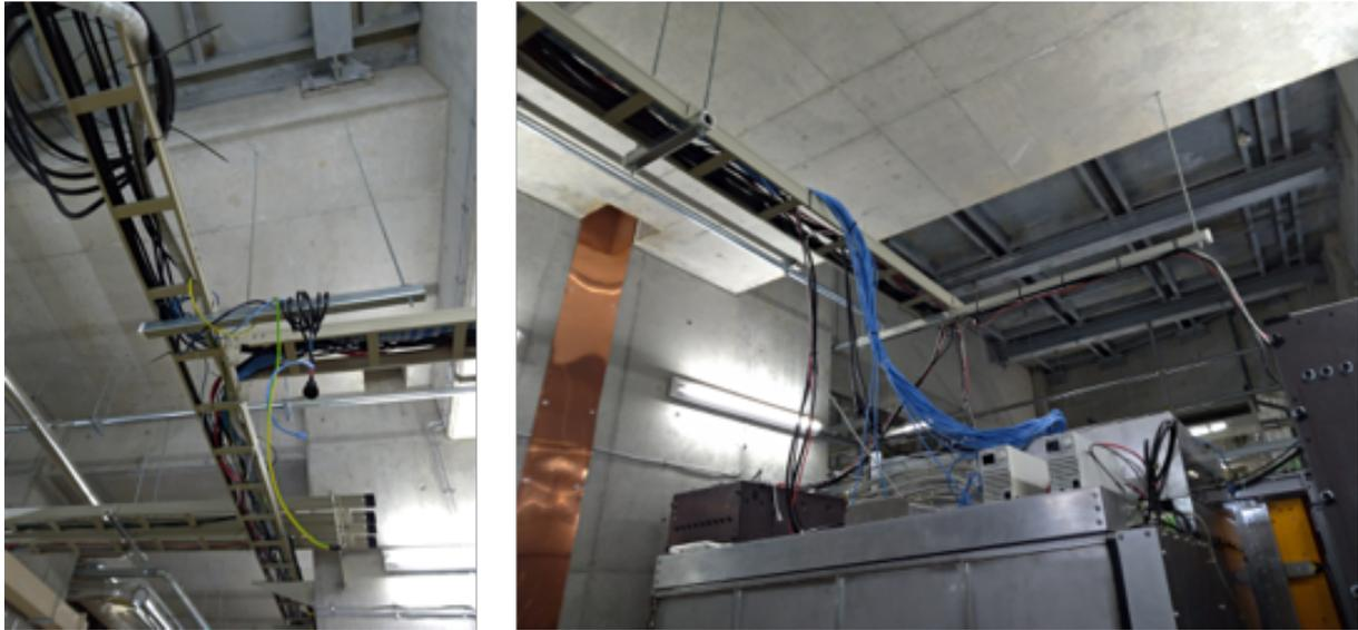
図 70: 配線作業の様子。天井ラック (左図) を用いて各検出器から配線が伝っている (右図)
